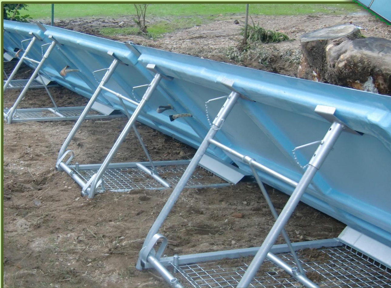
Umístění protipovodňových bariér v terénu ( Chrastava – srpen 2010 )
