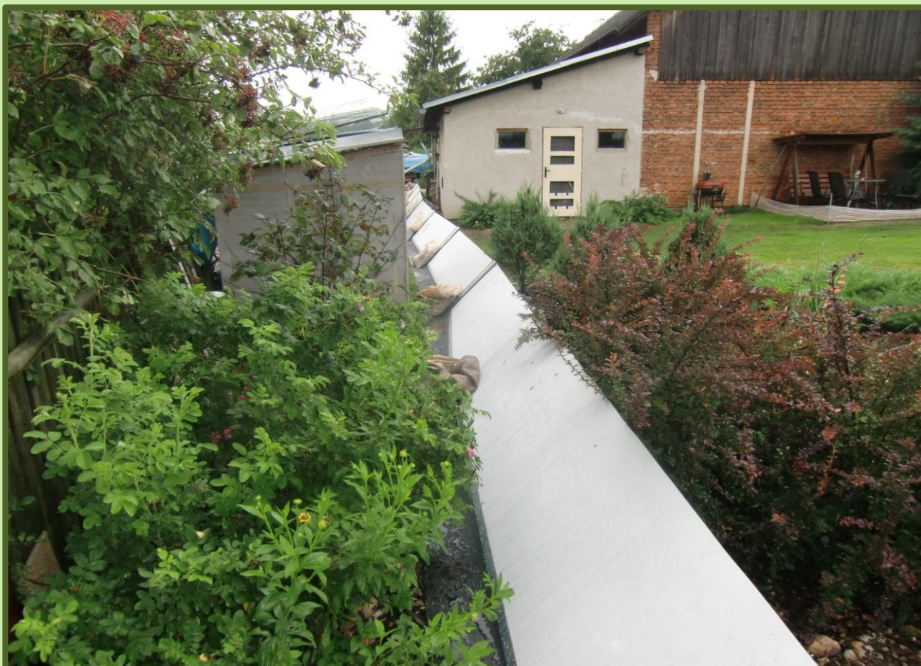
Umístění protipovodňových bariér v terénu ( Chrastava – srpen 2010 )
